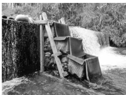
写真—19 組立完了
