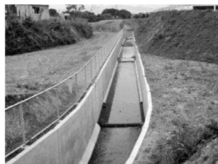
写真一九 三面張り水路 (2014年5月)
