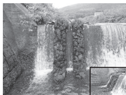
写真一三 石倉カゴ魚道実施例
