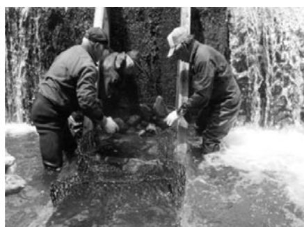
写真—18 蛇カゴ石詰
