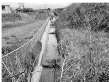
写真一〇 三面張り水路 (2015年3月)
