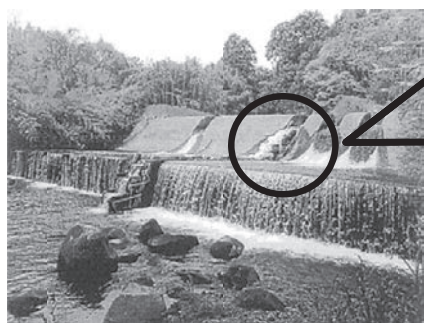
写真—15 魚道設置状況（右上段部、左下段部）
