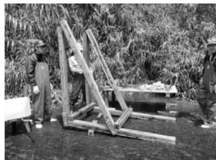
写真—17 木枠組立
