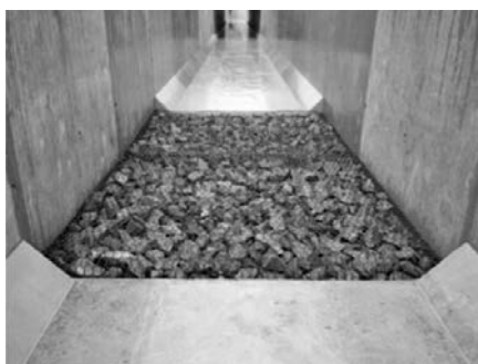
写真一八 生物生息場形成用蛇カゴ設置完了
