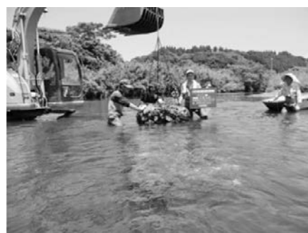
写真—3 重機による設置
