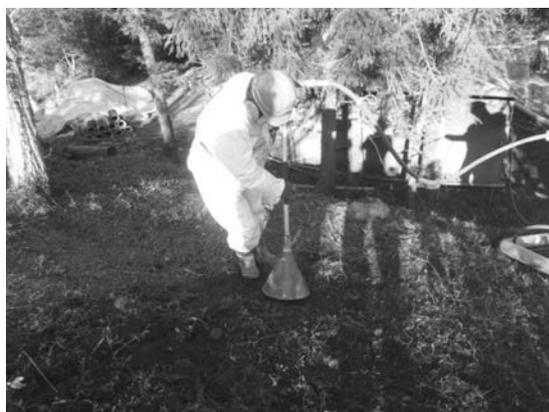
写真—9 ホレールによる腐葉土層のほぐし作業
