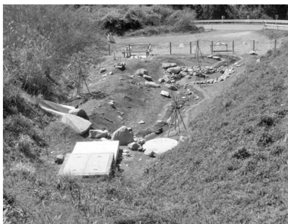
写真—4 ホタルビオトープ施工直後
