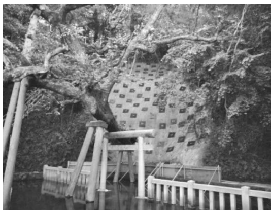
写真—9 鉄筋挿入工による安定化
