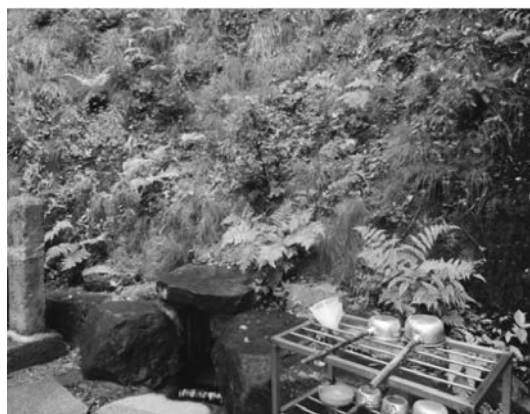
写真—11 復旧後の湧出口周辺斜面
