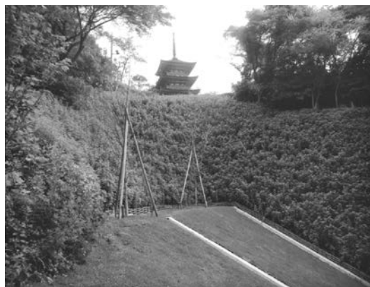
写真—7 植生工実施後の状況
