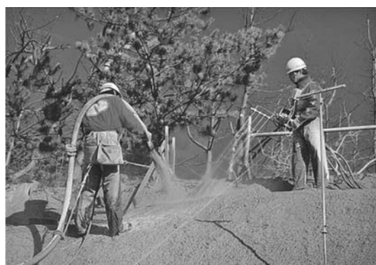
写真—1 連続繊維補強土工の施工状況
