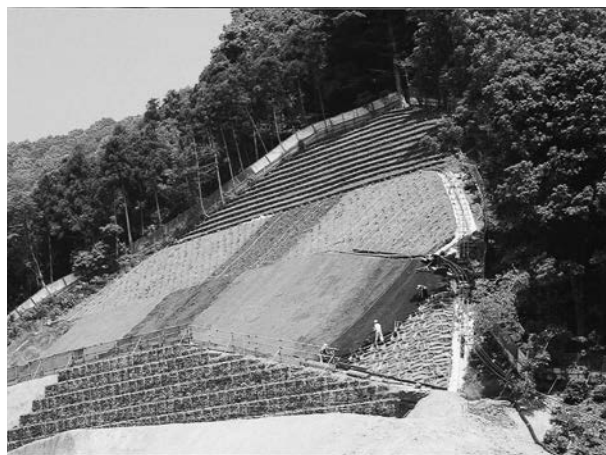
写真—6 植栽直後の切土のり面
