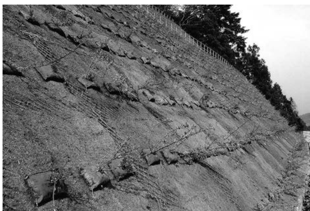
写真—9 切土のり面への植栽状況
