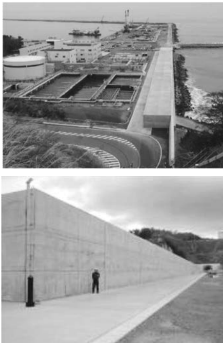
図—5 広野火力発電所防潮堤
