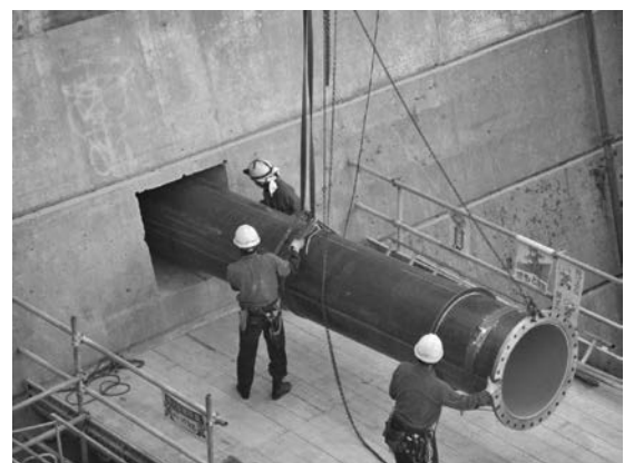
写真—3 取水管挿入状況
