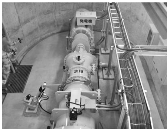
写真-6 水車発電機据付完了
