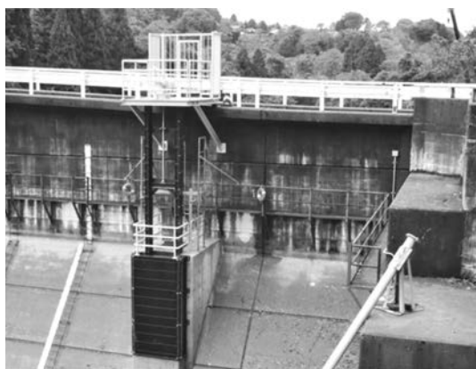
写真-4 取水口ゲート据付完了
