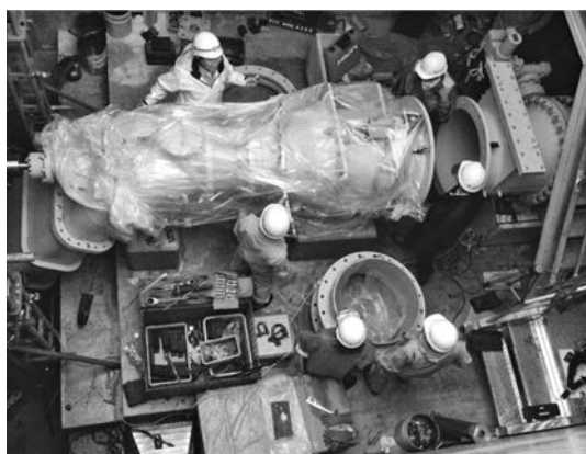
写真-5 水車据付状況
