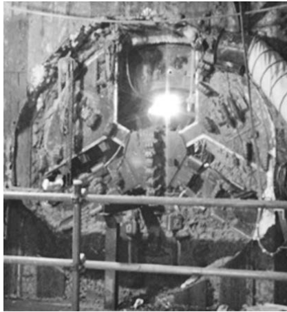
写真-4 2工区シールド到達状況
