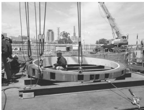
写真—4 セグメントの地上組立
