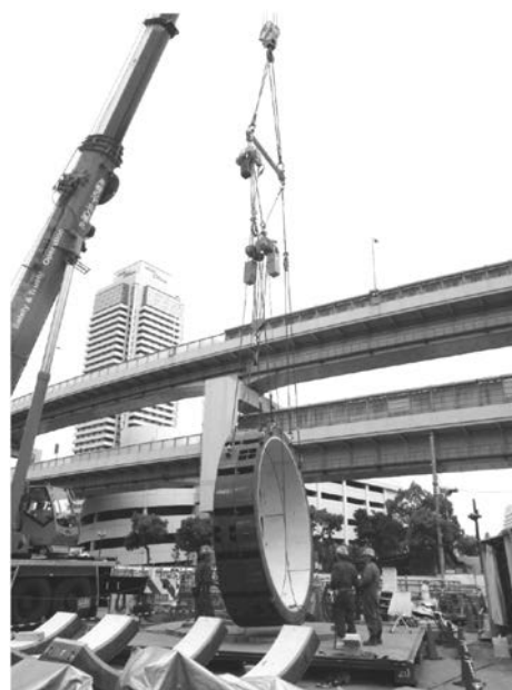
写真—5 セグメント投入
