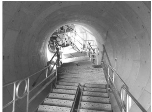
写真二〇 セグメント管路内部
