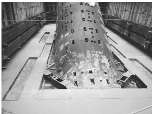
写真—3 開口補強鋼材（SRC 構造）
