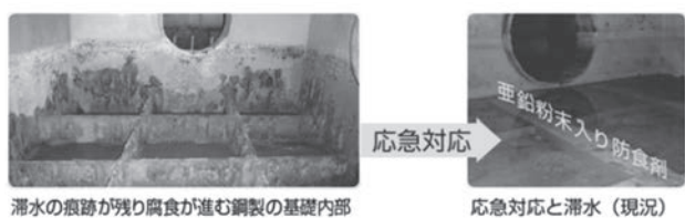
図—4 15号堺線（湊町付近）
