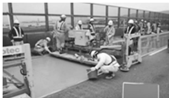
写真—4 SFRC舗装の施工状況
