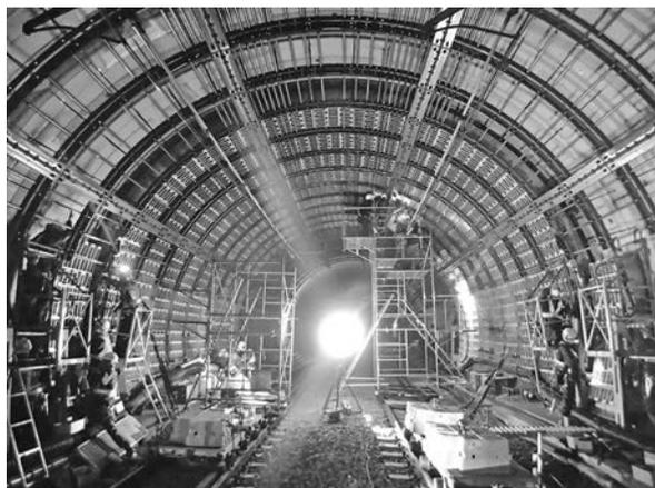
写真—6 内部補強工施工状況
