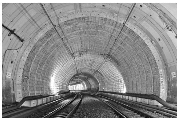
写真—7 内部補強工完了全景
