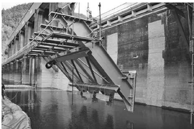
写真—5 鋼製架台（斜材）吊り込み状況
