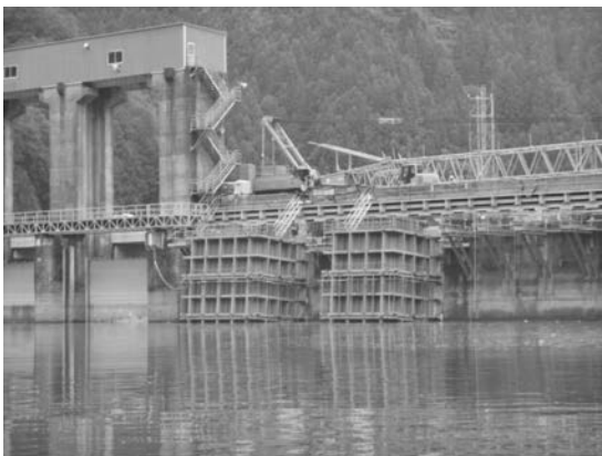
写真一9 仮締切設備据付完了
