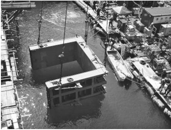
写真一8 仮締切扉体吊り込み状況
