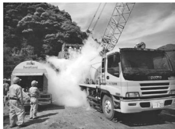
写真—6 液化窒素によるコンクリートのプレクーリング
