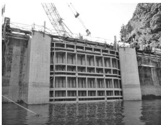
写真—12 予備ゲート扉体据付完了
