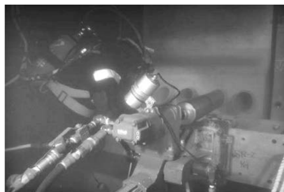
写真-3 アンカーボルト削孔状況（水中）
