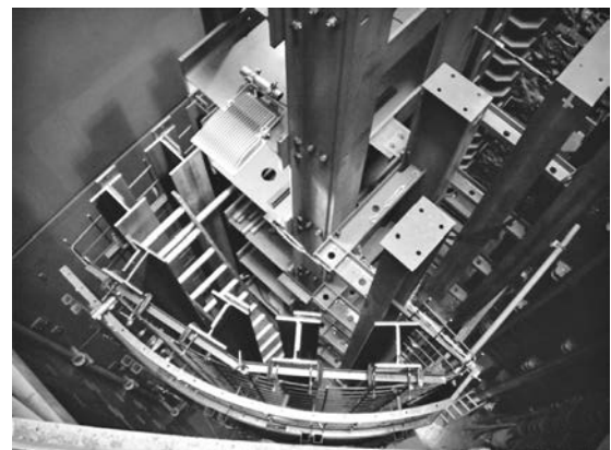
写真一10 予備ゲートピア施工状況
