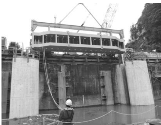
写真—11 予備ゲート扉体吊り込み
