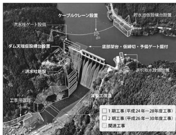
図—3 改造事業 工事施工範囲
