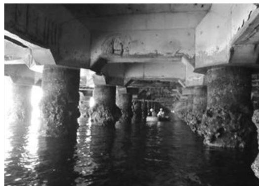
b) 栈橋下での作業状況
