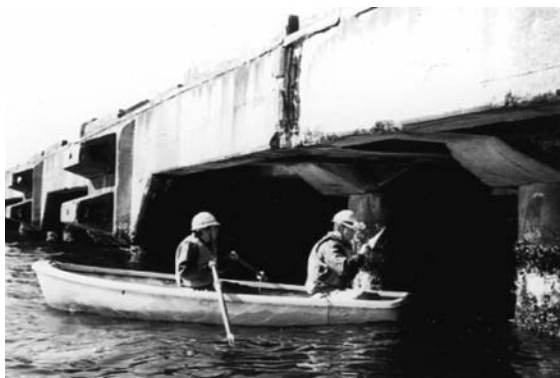
a) 上部工下への進入 状況
