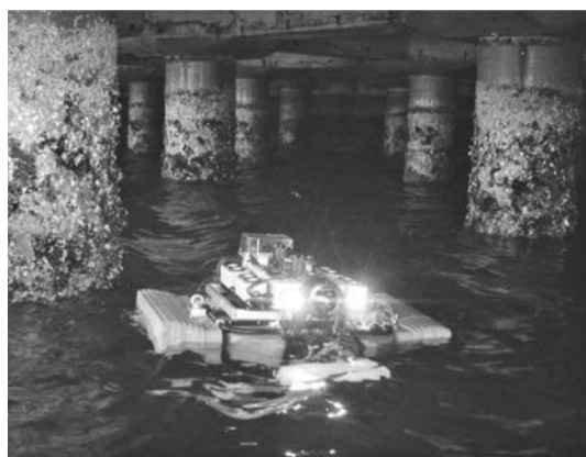
写真—4 栈橋上部工下でその下面を撮影中の ROV
