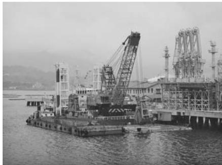
写真—8 LNG 栈橋前面 グラブ浚渫状況
