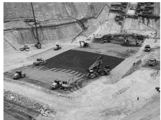
写真—2 堤体部盛立施工状況
