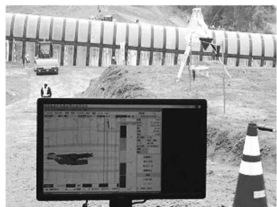
写真一3 締固め管理システム見学状況
