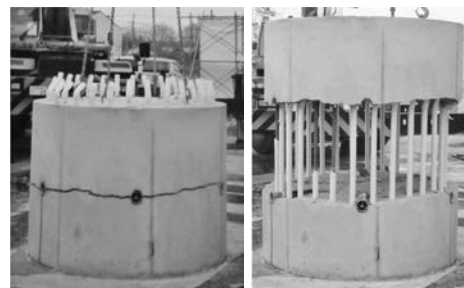
写真—1 ひび割れ状況
