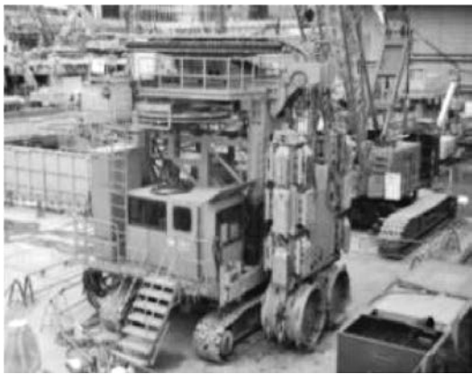
写真ー1 連壁掘削機
