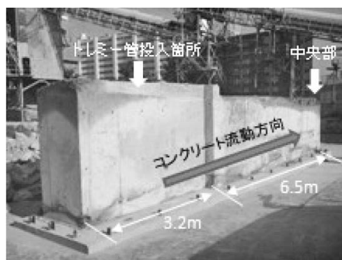
写真—6 高流動コンクリート試験
