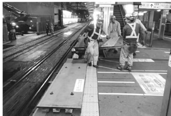
写真―1 人力による仮覆工の撤去状況
