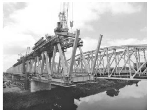
写真-7 架設状況（流水部）
