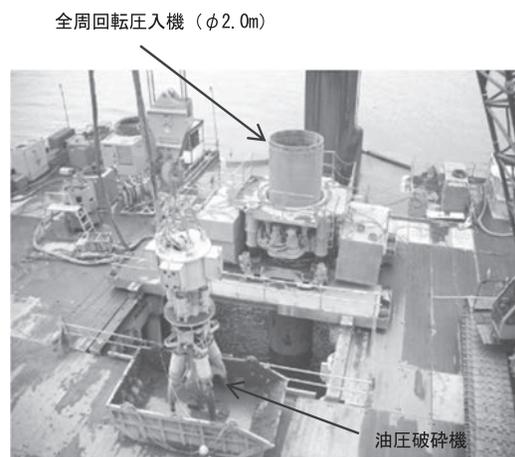
写真二 旧基礎撤去状況
