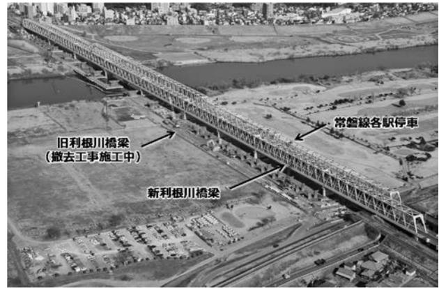
写真-11 撤去工事施工状況 (H28.1月現在)
