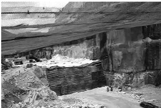
写真一七 ステージ3 発破防護工設置状況
