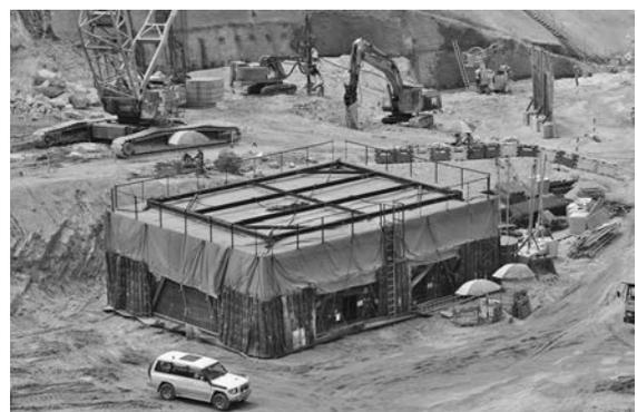
写真一4 ステージ1 発破防護工 (ダブルケージ方式)
