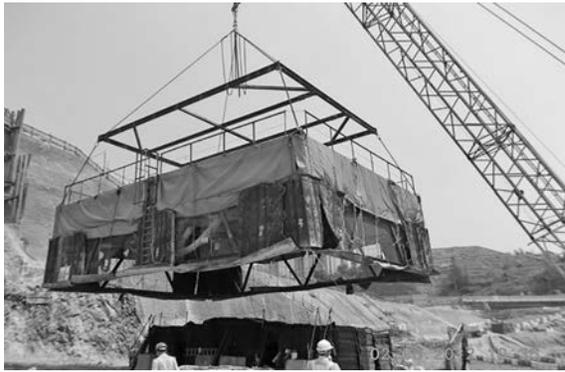
写真一六 ステージ1 発破防護工設置状況
