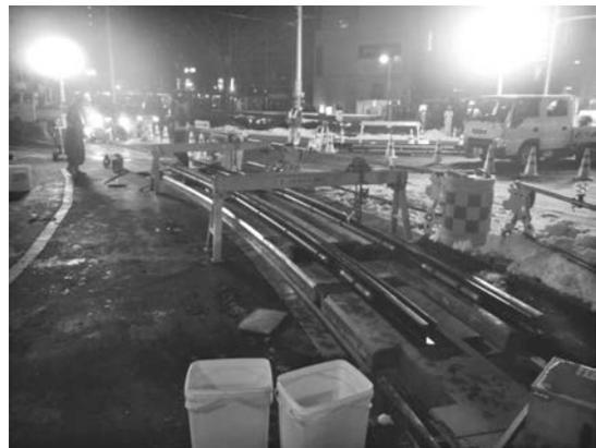
写真-5 レール据付状況
