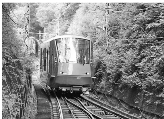
写真一15 完了全景
