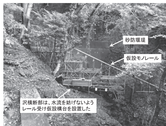
写真—3 砂防堰堤部
