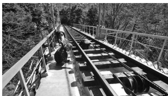
写真—11 橋面上での防水施工状況
