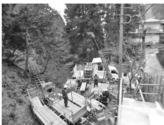
写真—1 仮設モノレール発進基地
