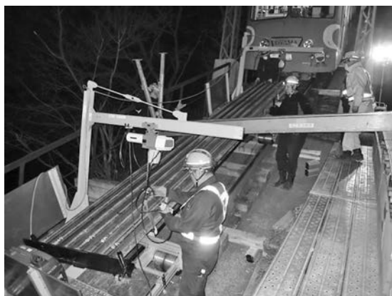
写真—5 既存ケーブルカーを活用した資機材運搬状況
