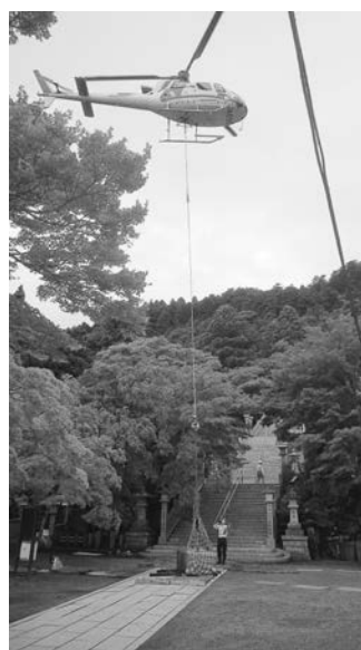
写真—7 仮設材空輸状況（阿夫利神社駅付近）
