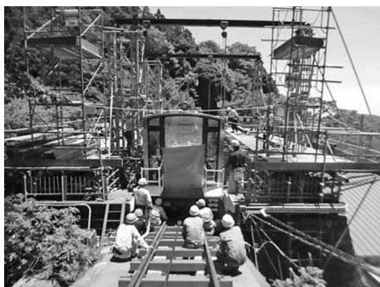
写真一14 新型車体と台車の結合状況
