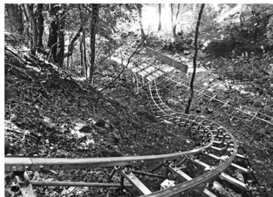
写真—2 スイッチバックと45°の急勾配
