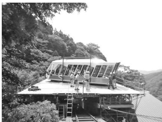
写真一13 搬入直後の新型車体
