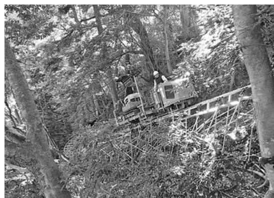
写真—4 小型バックホウ運搬状況
