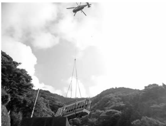
写真—8 新型車体搬入状況
