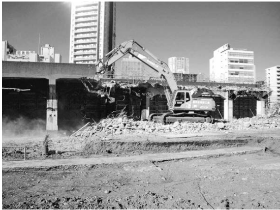
写真—5 旧高架橋撤去状況
