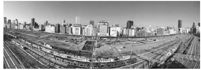
写真一八 品川車両基地全景 (手前 暫定供用中車両基地 左 横浜方 右 東京方)
