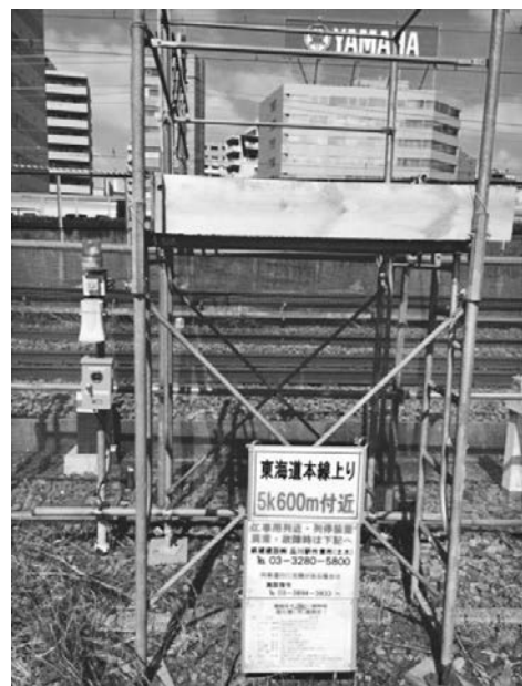
写真—7 列車停止ボタン及びキロ程看板・通報マニュアル
