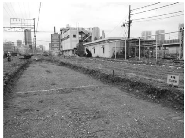
写真-2 路盤試験施工状況
