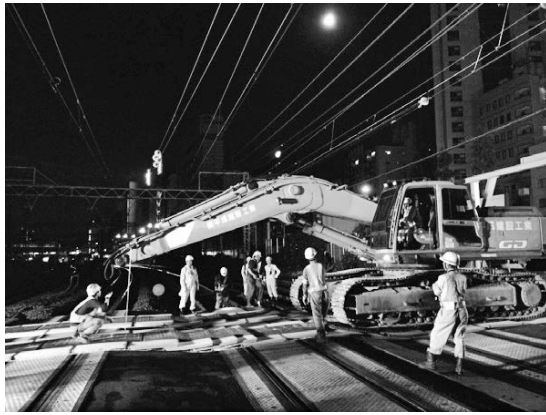
写真一 3 重機線路横断状況 (0.16 m 3 バックホウ)
