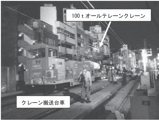
写真－2 クレーン運搬台車
