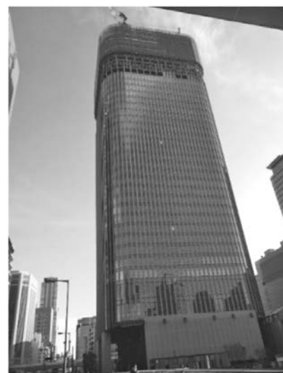
写真—6 現況の建物外観全景
