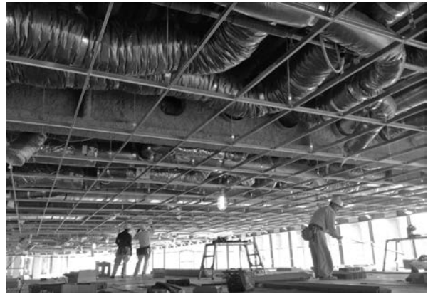
写真—4 天井工事の状況
