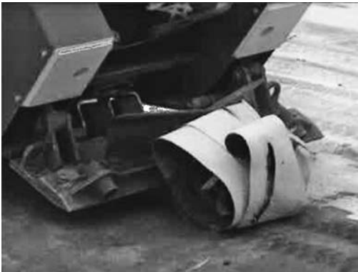
写真ー5 搭乗式スクレーバ HBS-2000 ライノス (施工時)
