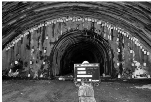
写真—4 補助工法施工状況（崩落箇所）
