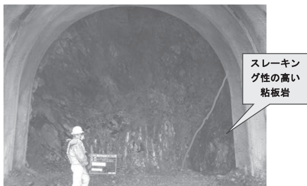
写真—1 支保No.11 切羽状況
