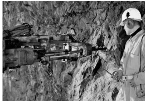
写真—2 受振・発振孔削孔状況
