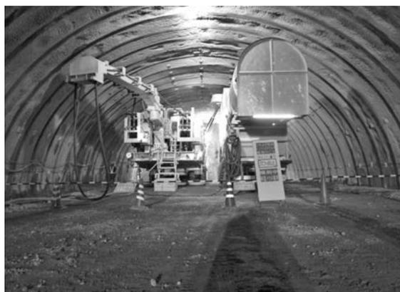
写真一〇 掘削状況（掘削機と集塵機をセット）
