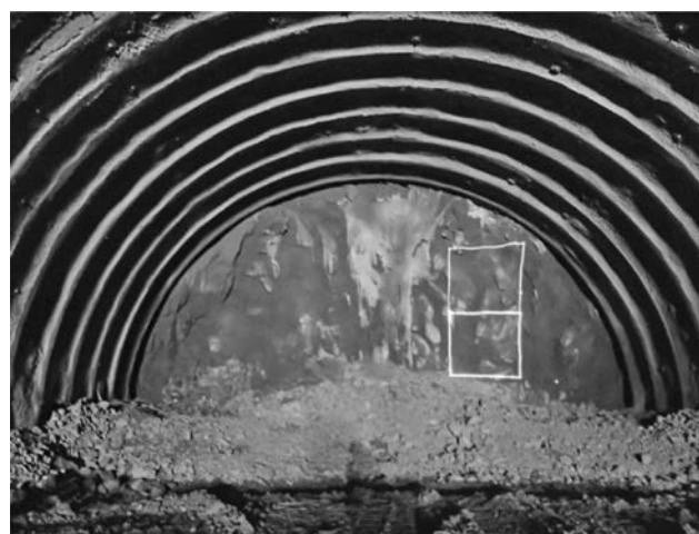
写真四 切羽へのレーザーマーキング
