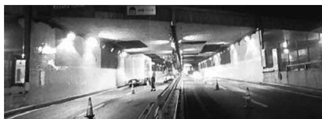
写真一八 適用トンネル
