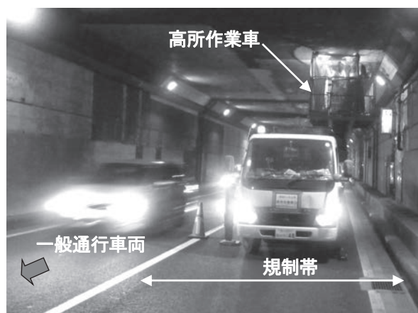
写真—1 トンネルの補修・補強工事
