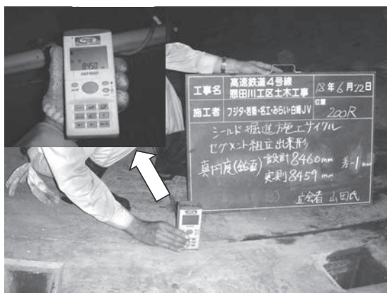
写真—1 従来のセグメント真円度計測方法
