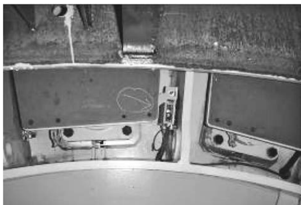
写真—4 計測ユニット設置状況
