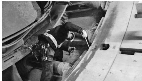
写真—3 従来のテールクリアランス計測状況
