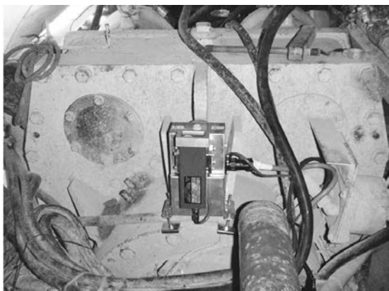
写真-5 計測機器設置状況（上側）
