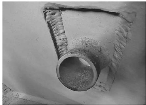
写真一 6 後工程の配慮無 注入管ネジが塗装やゴミで汚い
