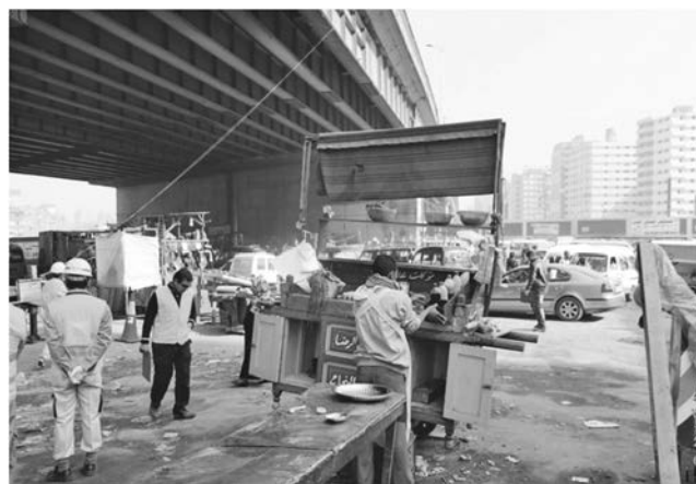
写真—4 街中での橋梁点検
