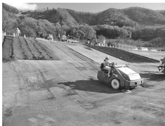
写真—3 スリーパによる清掃作業状況
