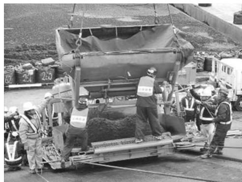
写真-6 合材供給専用ホッパによるアス合材供給状況
