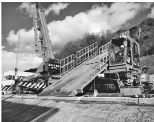
写真-4 MWP 全景
