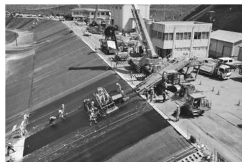
写真-7 斜面舗装施工状況全景
