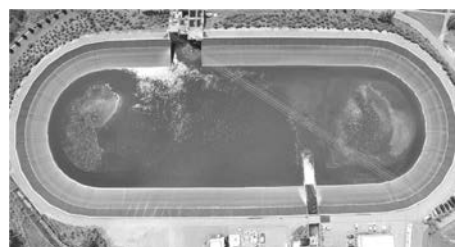
写真-8 現場完成写真
