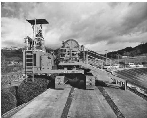
写真—1 定張力 SWP 全景
