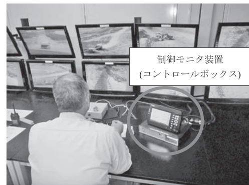
図一 6 MG 施工状況
