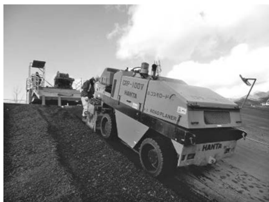
写真—2 切削機使用状況
