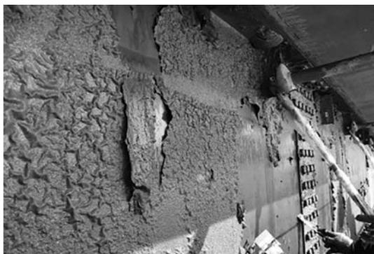
写真一1 塗膜剥離状況
