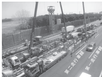
写真—7 地盤改良施工状況
