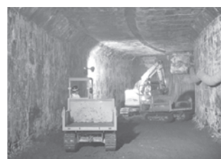
写真—11 内部掘削状況
