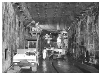
写真-12 セグメント撤去状況
