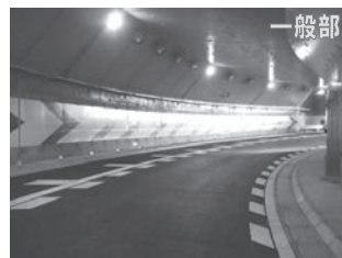
写真-15 完成トンネル内
