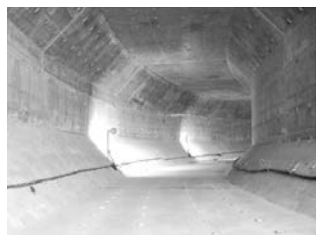
写真-13 トンネル完成
