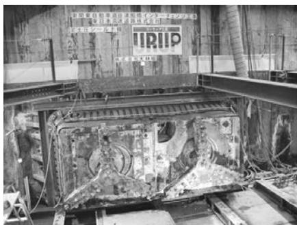
写真—3 下段シールド（横・密閉型）
