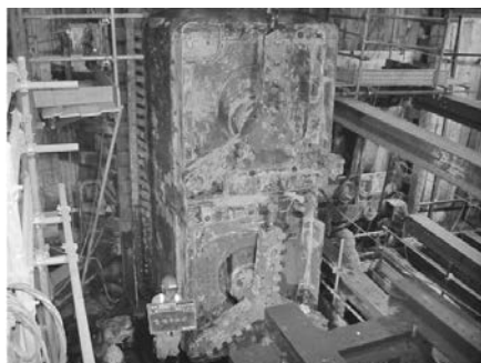
写真—4 中段シールド（縦・密閉型）
