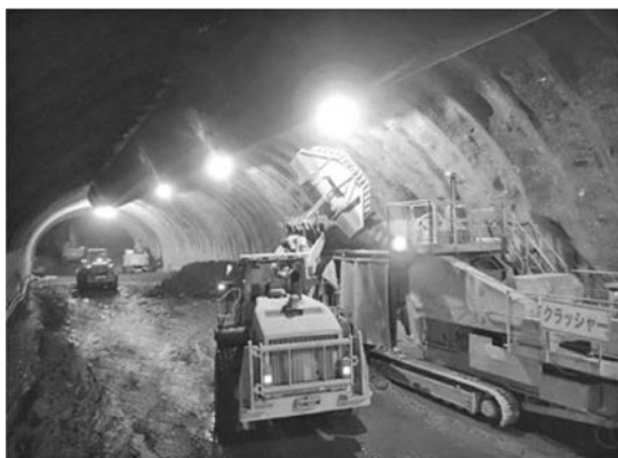
写真一4 ストックずり処理と切羽作業の同時作業
