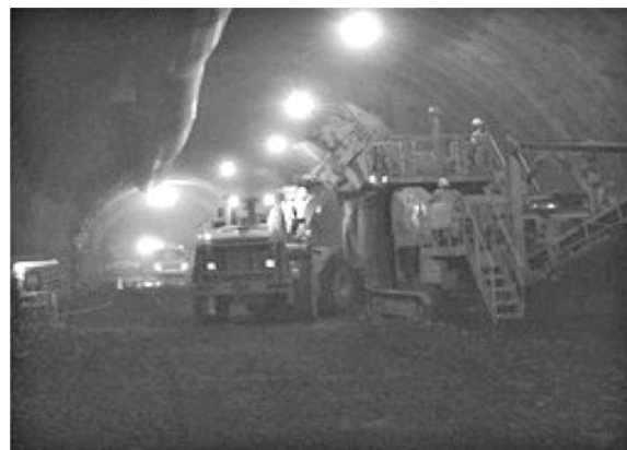
写真—3 ホイールローダ2台でのずり出し
