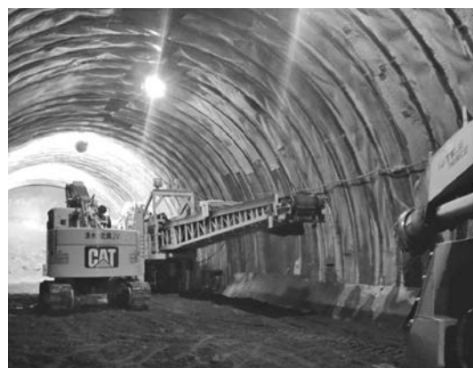
写真—2 実証実験状況（厚賀トンネル）
