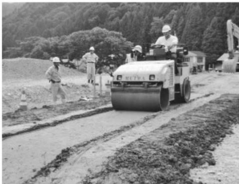
写真一 1 INSEM 工法の施工状況
