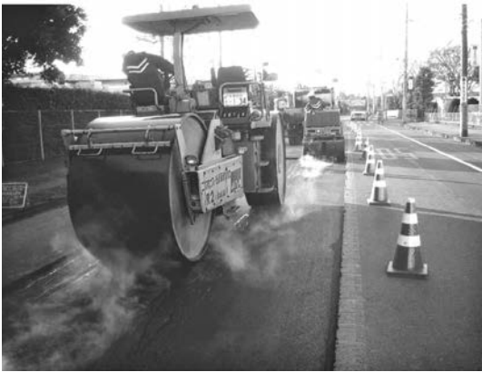
写真一4 転圧状況
