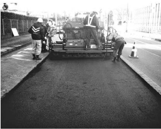
写真一3 敷きならし状況
