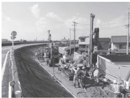
既設河川堤防上における施工状況
