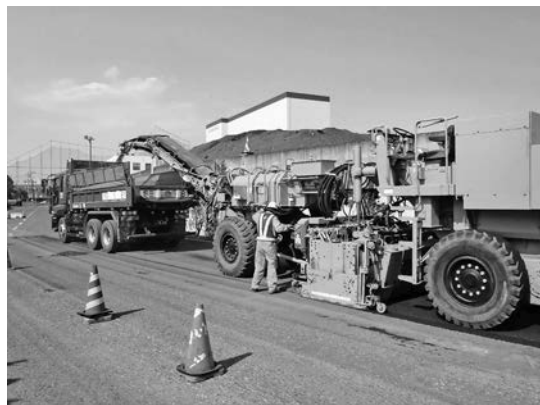
写真一 切削作業風景
