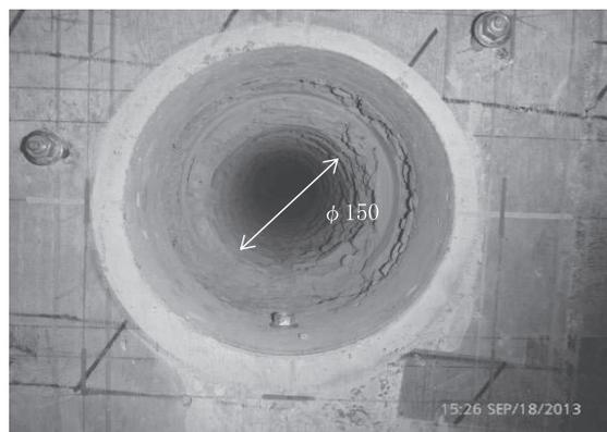
写真一6 WJ拡径削孔
