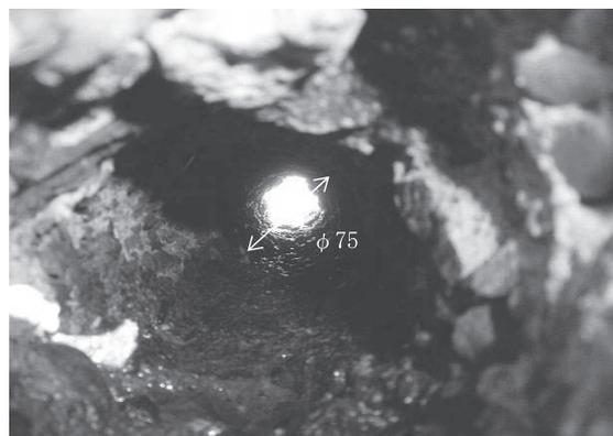
写真一5 WJ小径先行削孔
