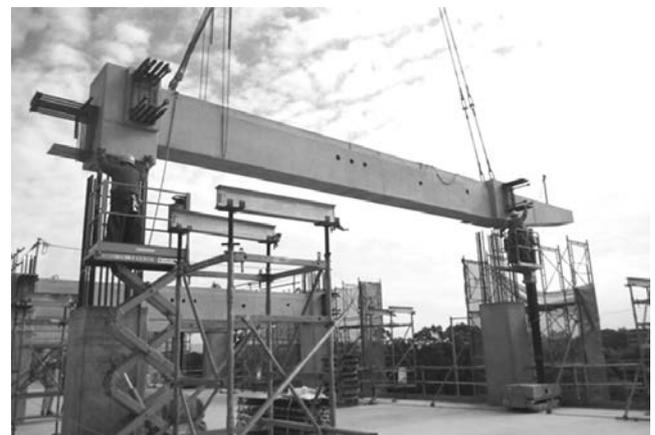
写真一2 柱梁接合部一体型 PRC 梁
