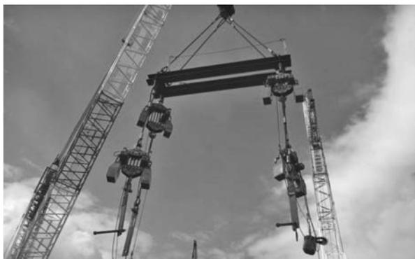
写真-12 傾斜回転用治具（トラバース&amp; 30tチェーンブロック）
