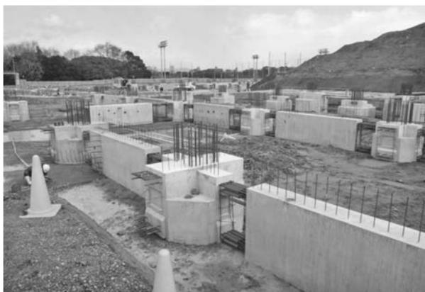
写真—4 基礎PCa配置状況
