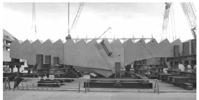
写真-7 大型PRC斜梁地組状況（コーナー部材）
