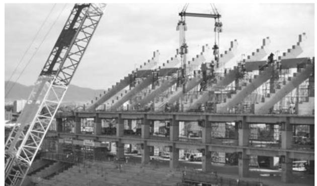
写真一11 600tクローラーによる広旋回範囲での揚重
