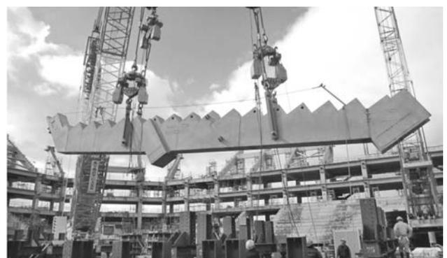
写真-9 圧着接合完了及び頂部サイトPCa接合後の地切り状況
