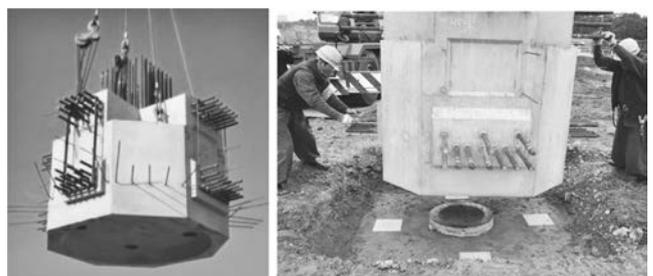
写真-3 フーチングPCa取付状況
