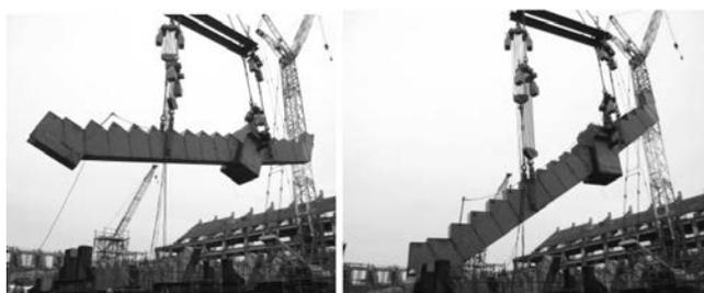
写真-13 電動チェーンブロックのリモコン操作にて35°傾斜実現
