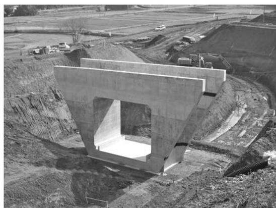
写真—12 函渠構造物完成写真
