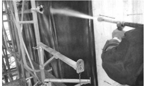
写真一10 養生マット散水状況
