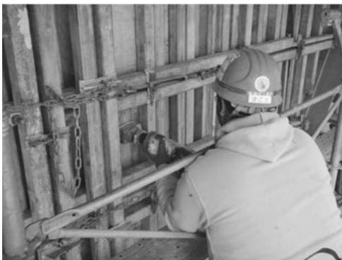
写真—5 壁打ちバイブレータ
