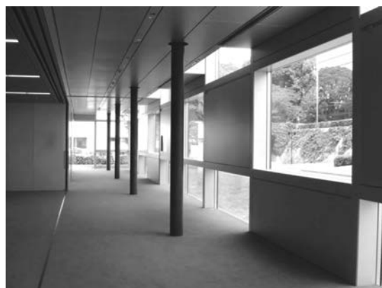
写真—7 RC 長柱の設置状況
