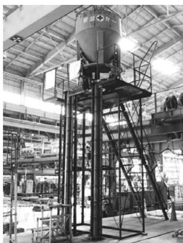
写真—5 コンクリートの打込み状況
