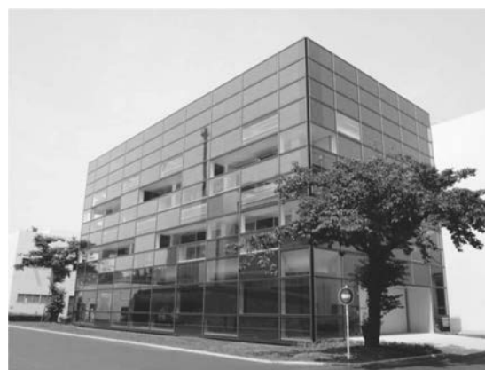
写真—4 建物の外観
