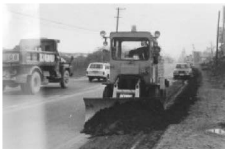
写真 7-32 小形除雪車 (ブレード装置装着) MR120 (株日本除雪機製作所 昭和 44 年)
