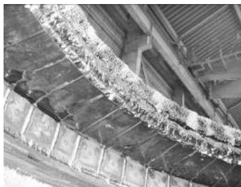
写真—3 FH ブラシ注入完了
