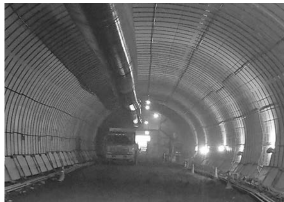
写真—1 うるおい（給水タイプ）の養生状況
