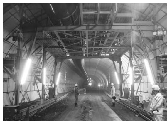
写真—2 移動用台車（自動昇降装置付）
