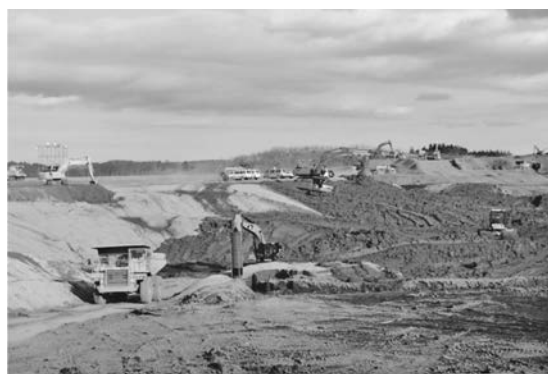
写真—2 大型重機稼働状況
