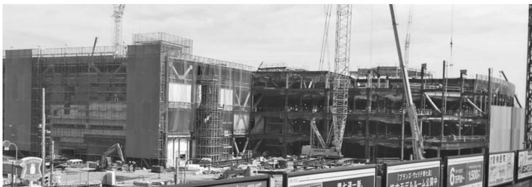
写真-1 イオンモール堺鉄砲町作業所の施工中の外観写真
