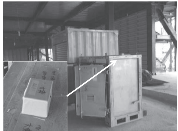
写真一 5 資材置場の倉庫に設置したアプリケーション起動用 BLE 端末
