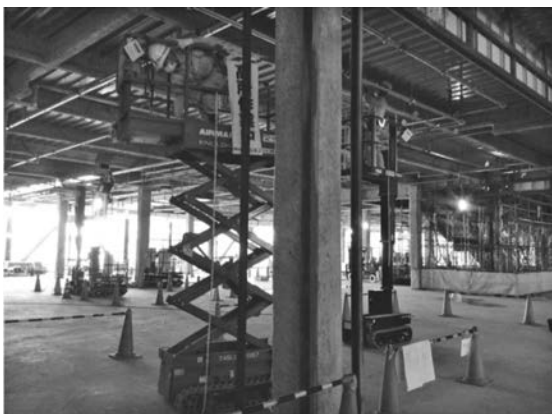
写真一 2 高所作業車を使った作業例
