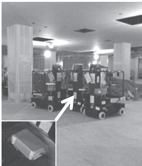
写真一 4 高所作業車に設置した無線発信機
